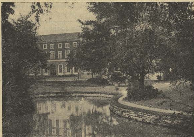
Façade intérieure. Parc.
