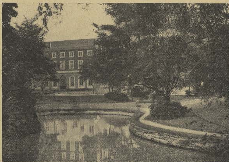
Façade intérieure. Parc.
