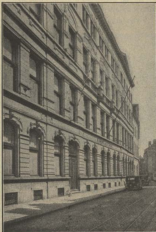
Façade de l'Institut Supérieur de Commerce à Anvers.
