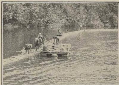
Fig. 13. — Jonctionnement des éléments flottants par des scaphandriers.
