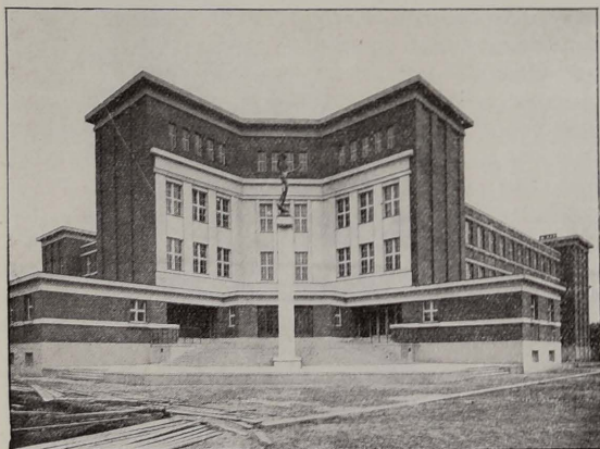
Gymnase Rasin à Hradec Kralové.
