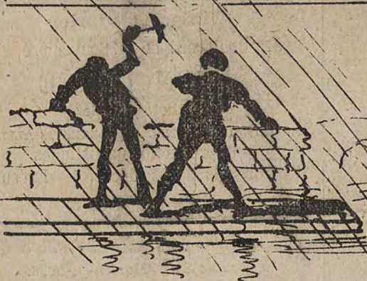
Les travaux de l'île de Commerce. Les maçons forcés de travailler sur des radeaux.
